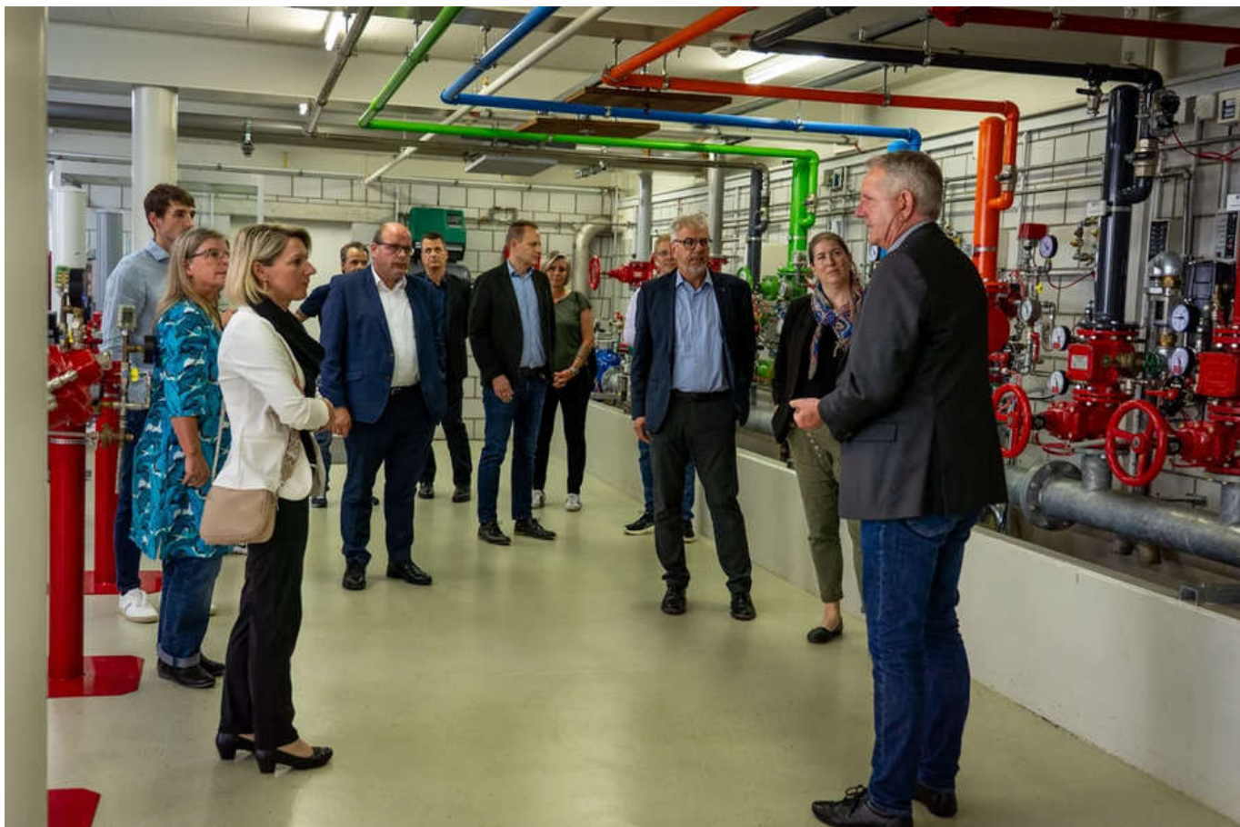
Im Ausstellungsraum von Jomos findet sich ein ganzes Sprinklersystem für Schulungszwecke. Bild: zvg/Naturpark Thal
